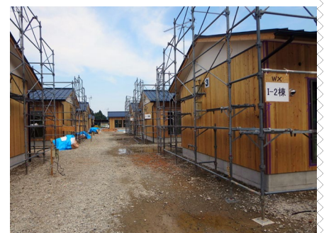
御船町 木造仮設住宅
