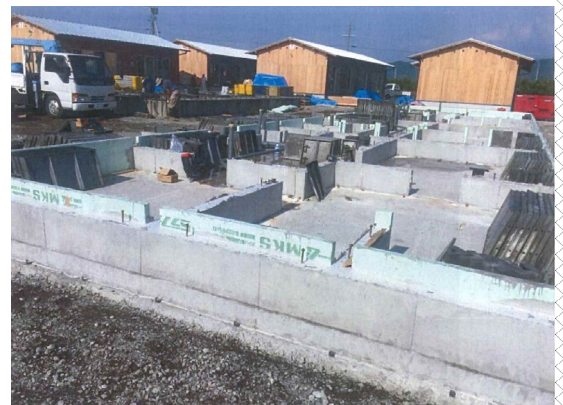
(熊本県木造仮設住宅とコンクリート基礎)
